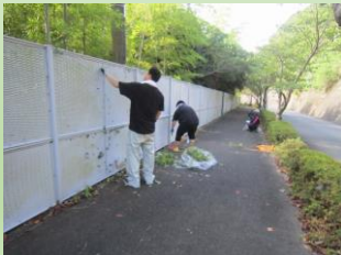
桜坂のフェンスに絡まる蔓の除去
