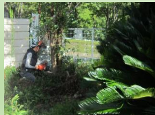
見通しを遮る樹木の伐採
