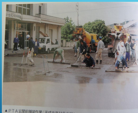
▲PTA玄関前舗装作業（平成8年11月3日）
