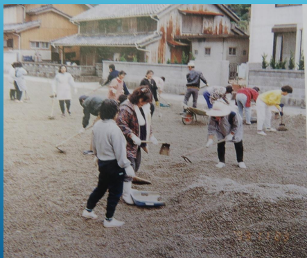
玄関前砂利敷詰め作業（平成5年11月23日）
