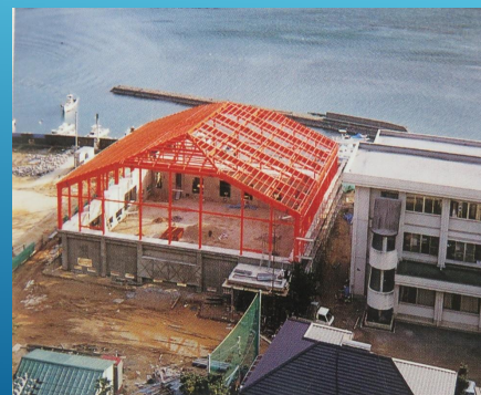
▲建設中の体育館
