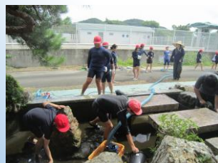
泥をバケツリレーで運ぶ。
