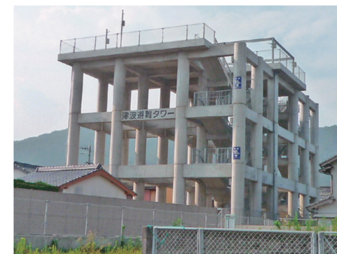
穴喰津波避難タワー(海陽町穴喰)
