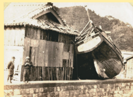
●「由岐町、湾岸に上がった船。堤防の高さは水面から約2m。」(気象庁ホームページより)
