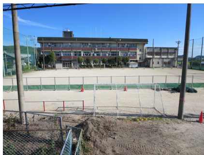
防球ネット張替工事
