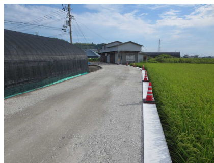
学校周辺道路の工事
