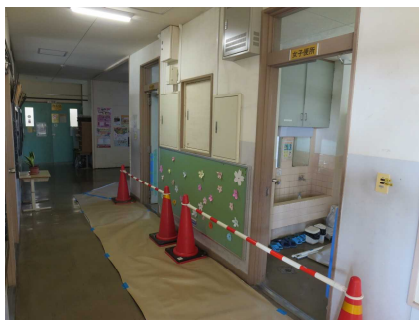
トイレの間仕切り工事
