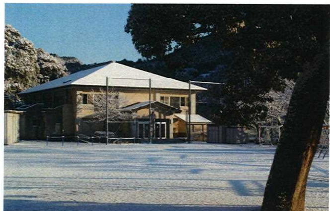
屋内運動場（平成27年1月25日撮影）
