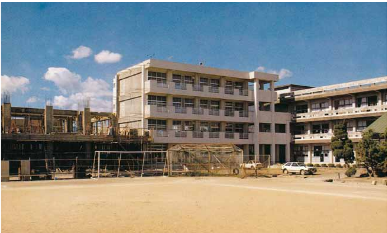
1980 (昭和55) 年 新館鉄筋4階建 (第2期工事の途中) 1981年2月24日完成
